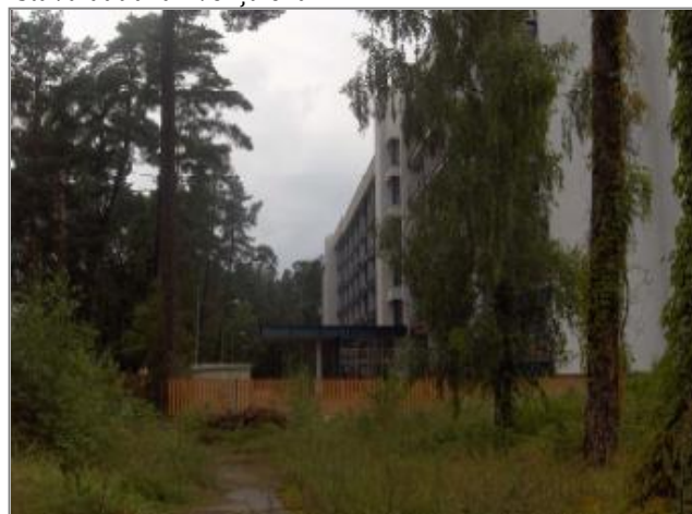
11.Attēls. No detālplānojuma teritorijas netālu esošā daudzstāvu daudzdzīvokļu apbūve.
