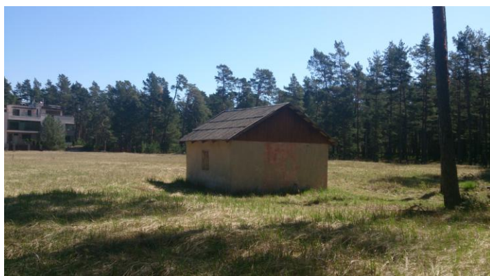
7. attēls. Teritorijā esošā apbūve – sūkņu ēka.
